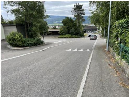
Abbildung 2 : Angehobene Einmündung mit durchgehendem Trottoir
